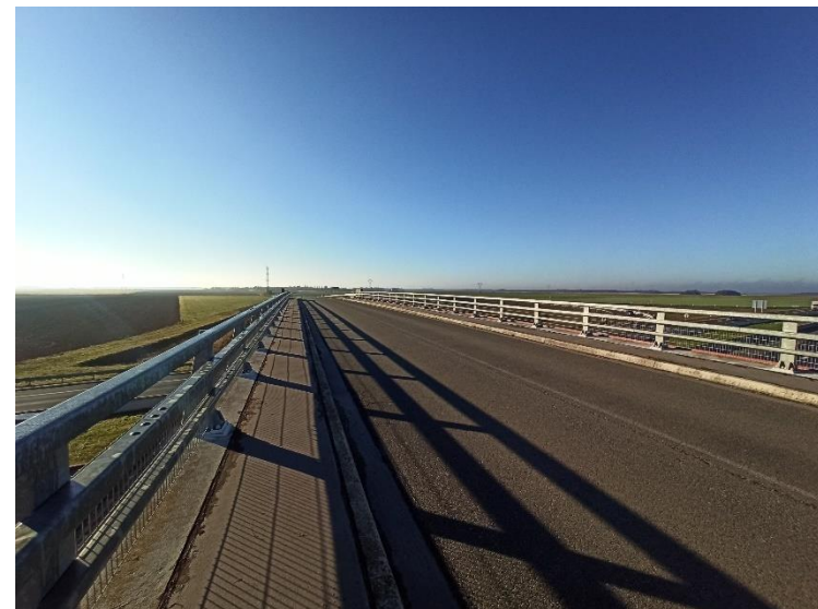
Trottoir sur le pont au-dessus de la RN12
